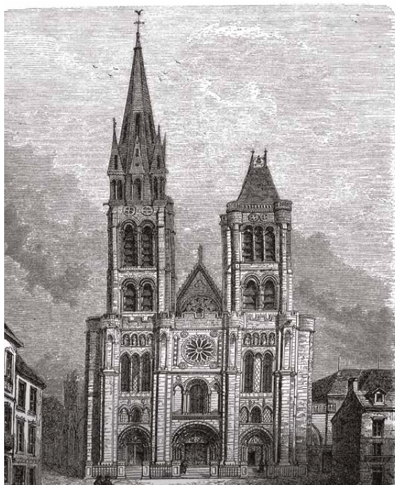
La basilique avec sa tour nord avant la démolition
