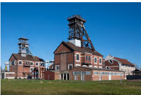
Chevalements miniers de la fosse 9-9 bis © Fondation du patrimoine - MyPhotoAgency-Baptiste Rutko
