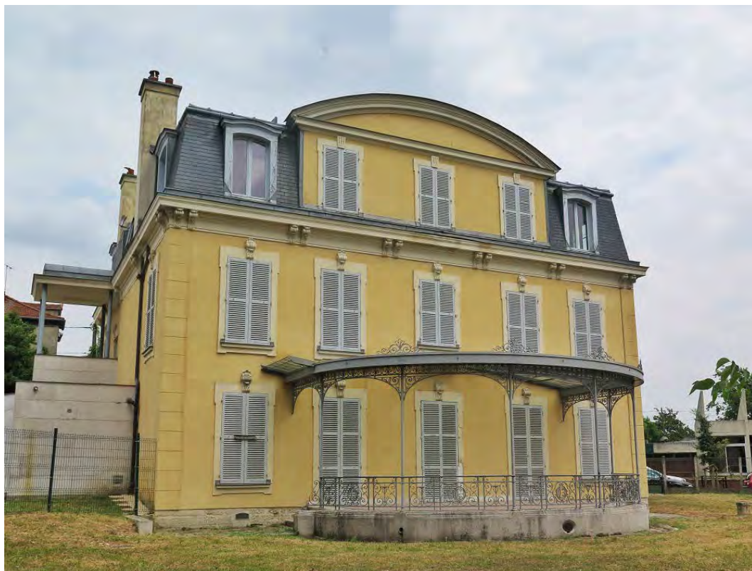
Château de Maison-Blanche à Gagny © Fondation du patrimoine
